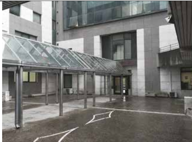
4. Stato di fatto del cortile tra gli edifici della Procura.
